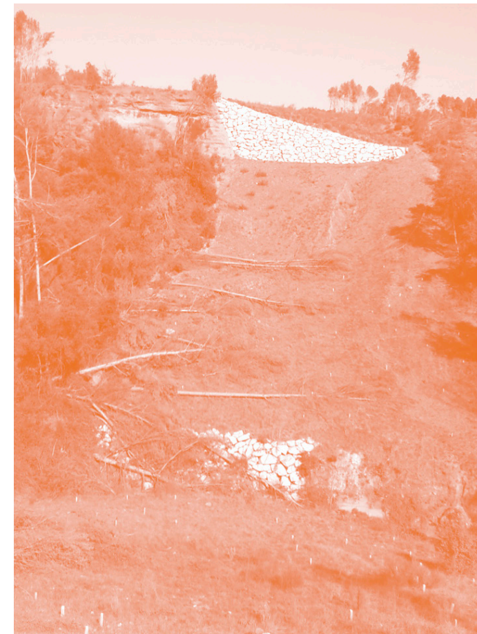
Imatge 1: Excursió de la població de Castellar del Vallès pel traçat del gasoducte MIDCAT/STEP (Torrent de Colobrers) una vegada acabava la seva construcció. Gener del 2012. Autoria: Xavi Arderius
