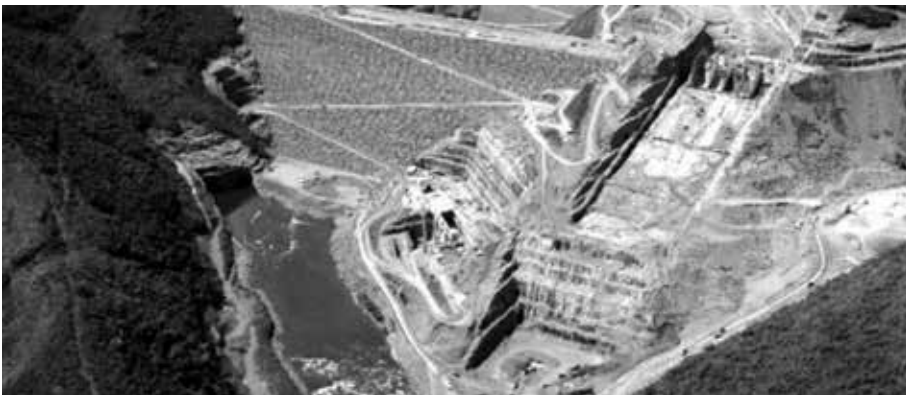
Construcción de la represa de Barra Grande en Brasil (Fuente: International Rivers)
