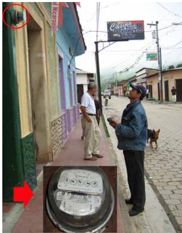
Fotografia presa a Quilalí, mentre un funcionari d'Unión Fenosa fa la lectura del consum del comptador, a simple vista. Com es pot veure en el detall que mostra la fotografia, per a cada dígit del lector, hi ha una maneta petita. Quants errors de lectura al dia poden donar-se?
