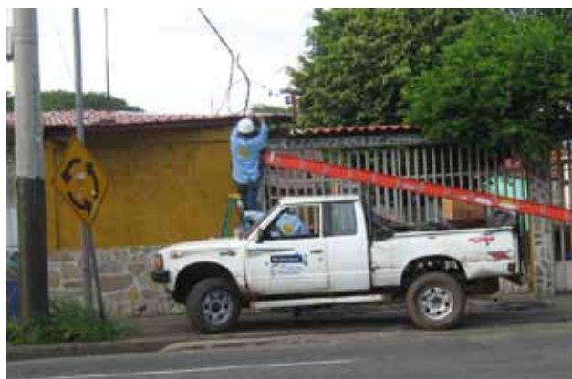
Operarios de Unión FENOSA procediendo al corte del suministro eléctrico.
